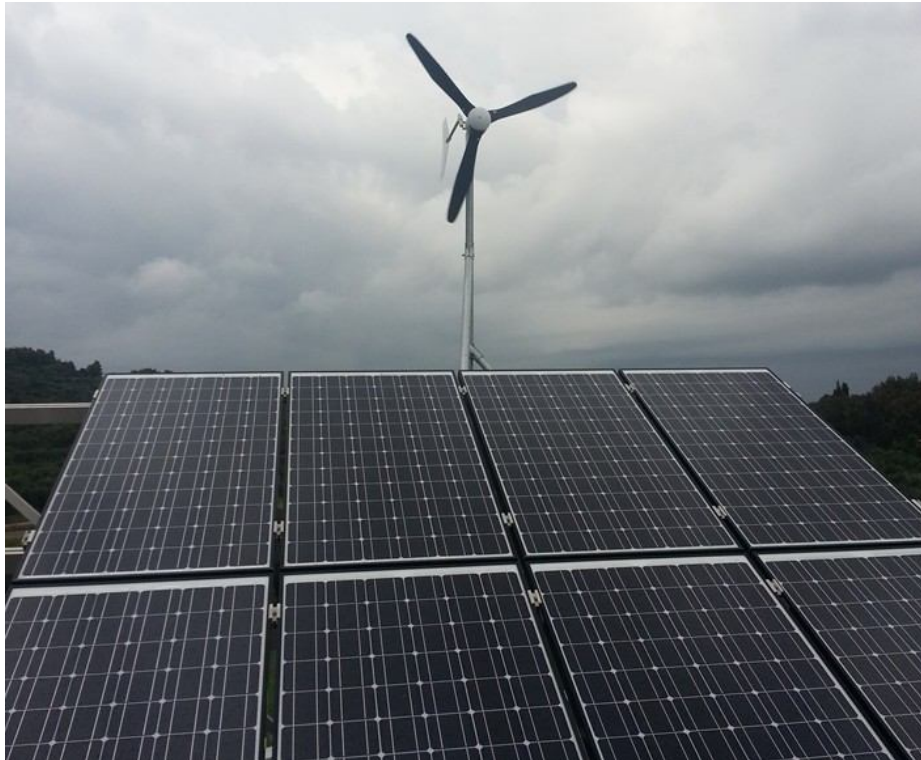
Ανεμογεννήτρια σε υβριδικό αυτόνομο φωτοβολταϊκό
